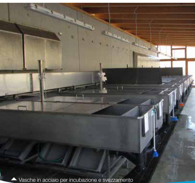
▲ Vasche in acciaio per incubazione e svezzamento
