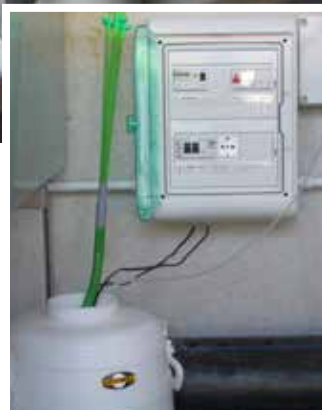
▲ Quadro di comando per la distribuzione automatica dell'artemia salina.
